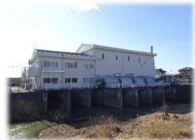
吉見排水機場
