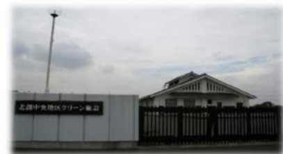
北部中央地区クリーン施設
