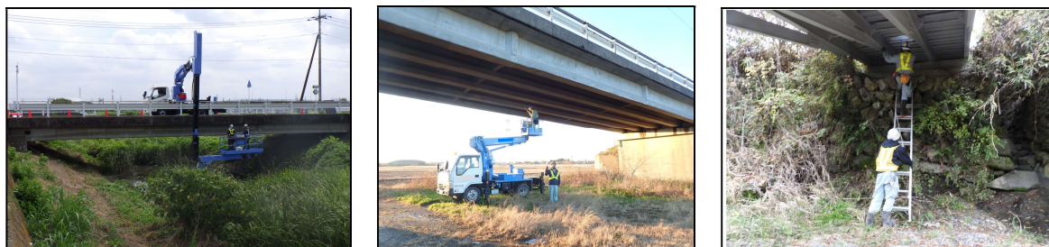
図-3.3 橋梁の点検状況
