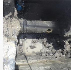
老朽化により水道管が破損した様子
