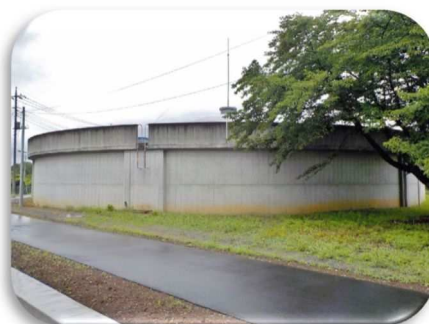
P C 配水池
