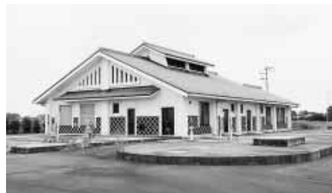
農業集落排水処理施設の「北部中央地区クリーン施設」
