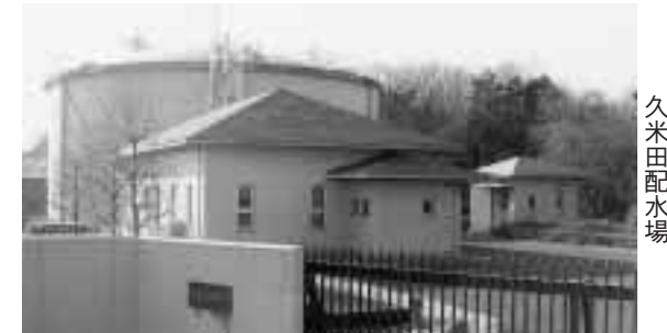
久米田配水場
