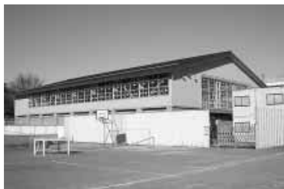
工事が進む北小学校屋内運動場
