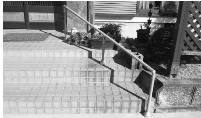
玄関前外階段の手すりの設置
