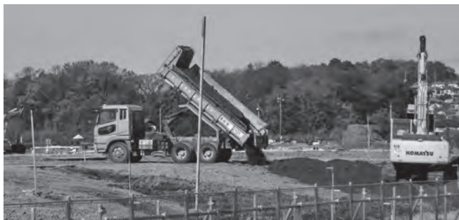
西吉見南部造成工事
