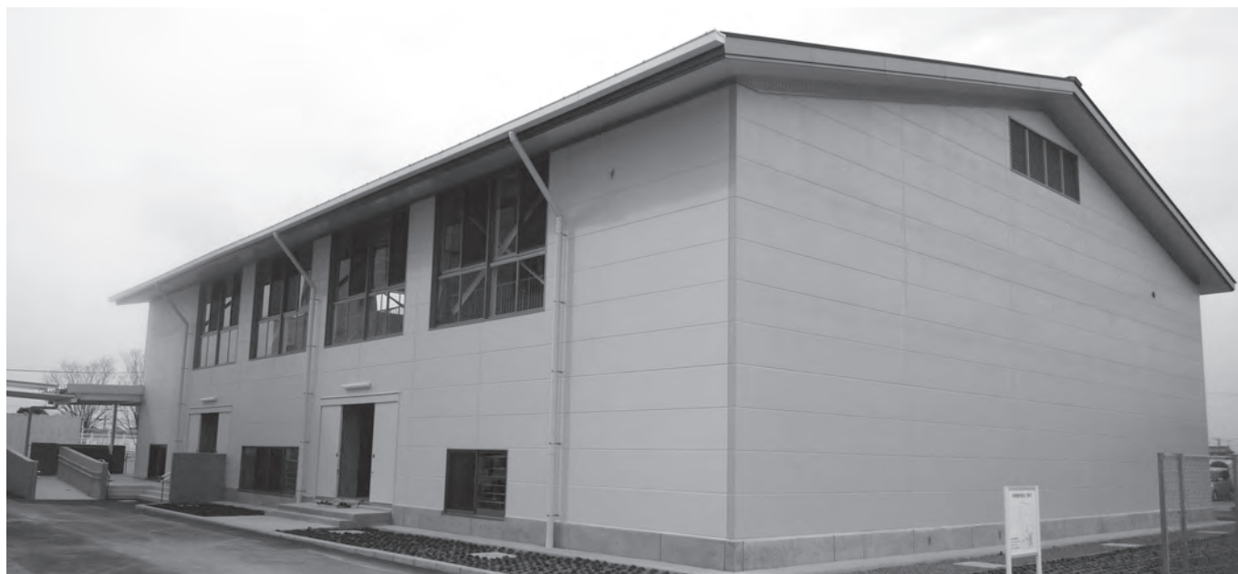
東第二小学校屋内運動場
