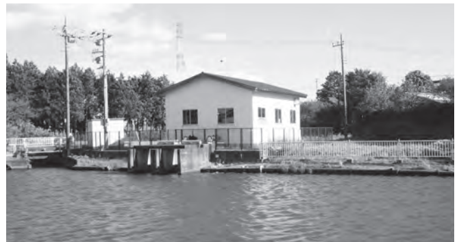
宮川揚水機場（一ツ木地内）
