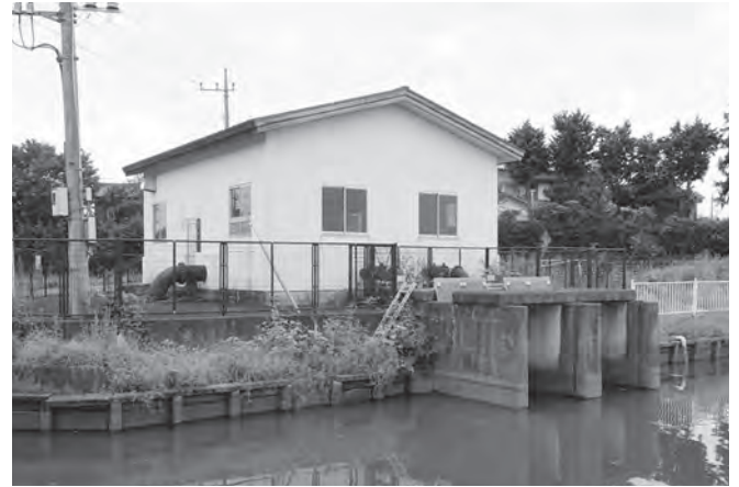
宮川揚水機場
