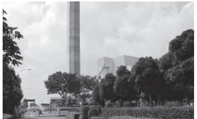
現在の埼玉中部環境センター
