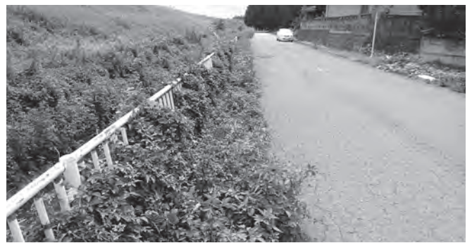
フェンス修繕(一ツ木)
