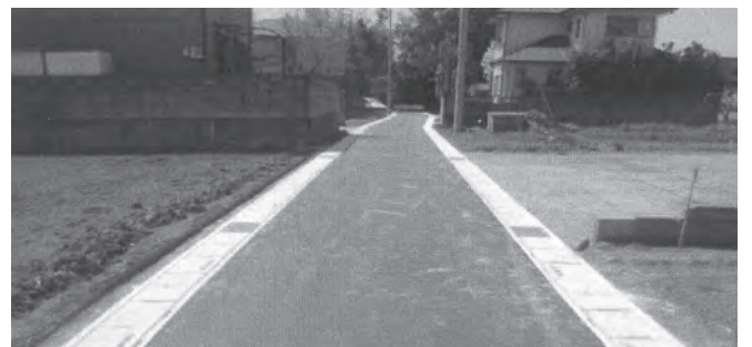
整備された中央市街化区域内の道路(久保田地内)
