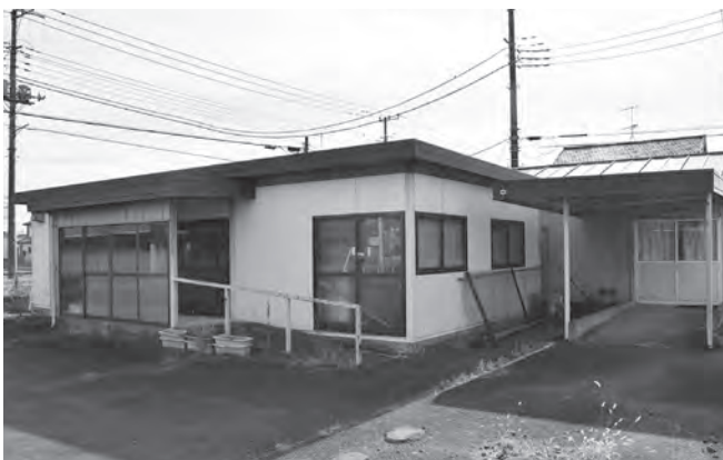
解体される旧デイケア施設ひばりの建物(下細谷)
