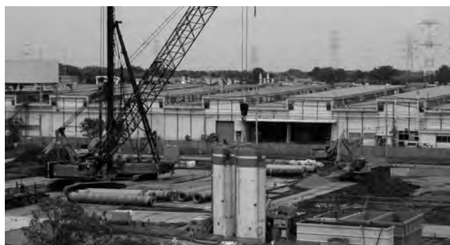
国内最大規模の最新自動物流センターの工事現場
