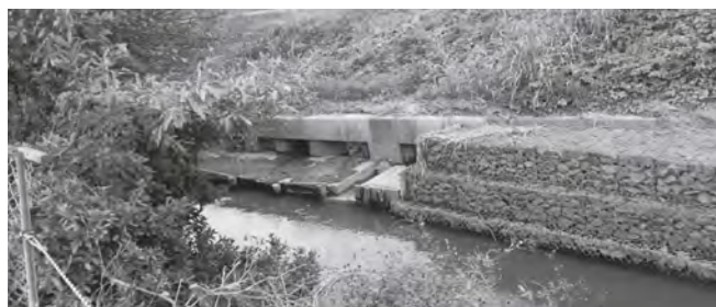
丸貫橋付近の泥水噴出場所
