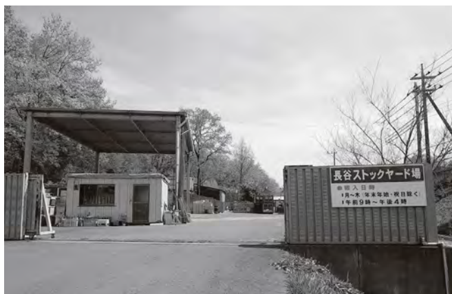
長谷ストックヤード場
