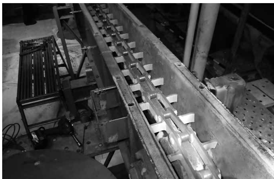
修繕後のコンベヤ内部のチェーンと底板
