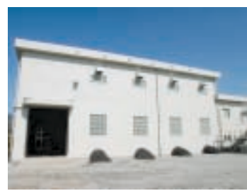
24 吉見排水機場
