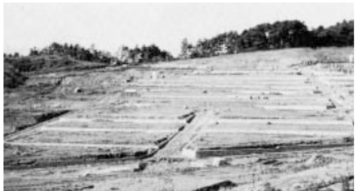
西地区宅地造成始まる
