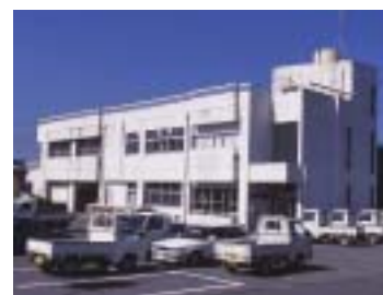
8 農業構造改善センター
