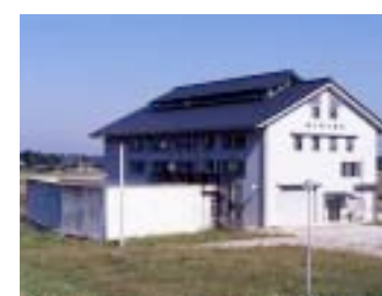
20 横見排水機場
