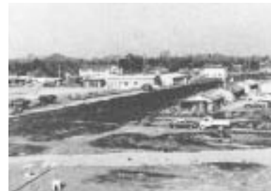
大型工場建設
