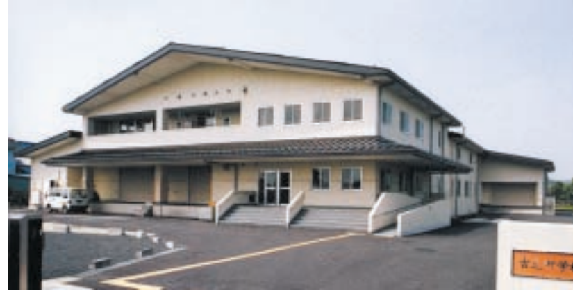
新給食センター完成
