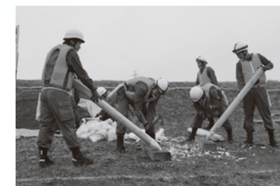
▲基本工法(杭ごしらえ)
