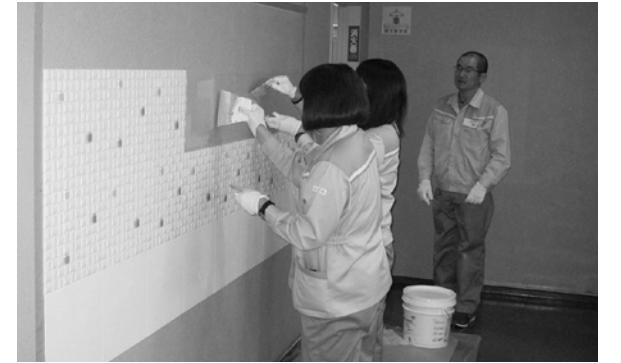
▲白いデザインタイルを壁一面に貼る様子
