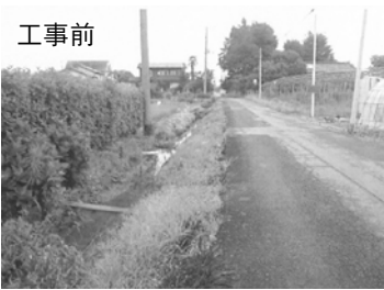
◆側溝整備工事の様子
