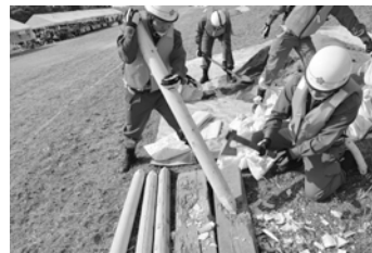
▲基本工法(杭ごしらえ)
