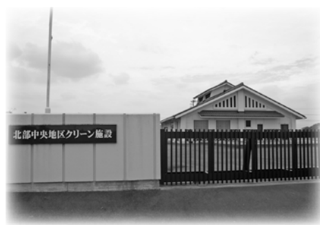
▲北部中央地区クリーン施設
