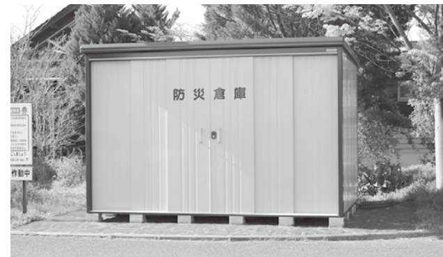
▲寄贈された防災倉庫 (道の駅いちごの里よしみ敷地内)
