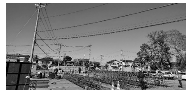
▲（仮称）久保田歩道橋下部工 杭基礎施工中
