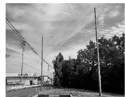
▲電柱・通信柱の移設工事
