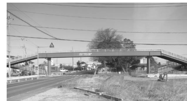
▲久米田歩道橋の新設
