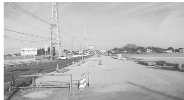
▲道路改築工事の施工状況
