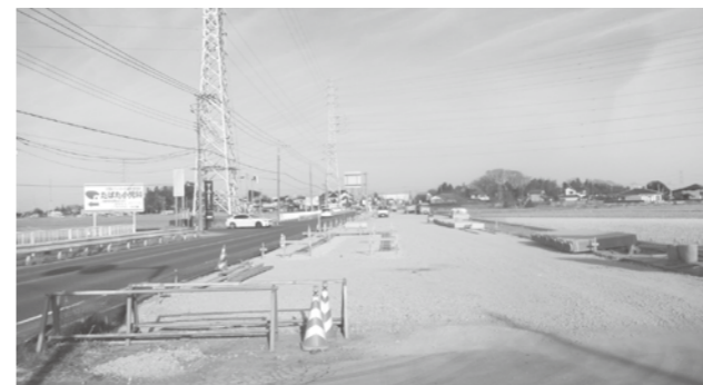
▲道路改築工事の施工状況
