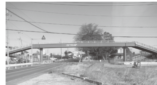
▲久米田歩道橋の新設
