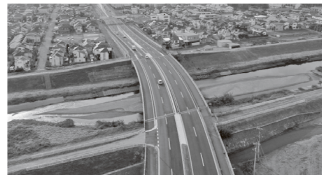
▲4車線供用開始状況(城南新宿橋から東松山市を望む)
