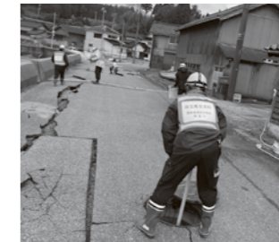
写真① マンホールを一つずつ開けて確認作業
