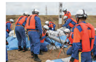
▲水防団員による月の輪工法
