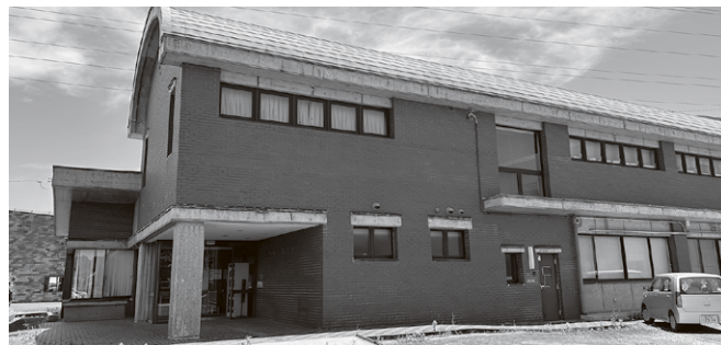
(仮称)こども家庭センターがここに開設されます
