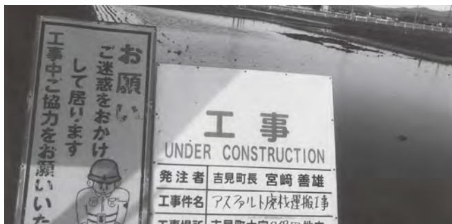
アスファルト廃材撤去後
