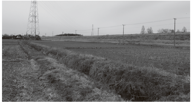
荒川右岸堤防未整備区間の1日も早い整備を求む
