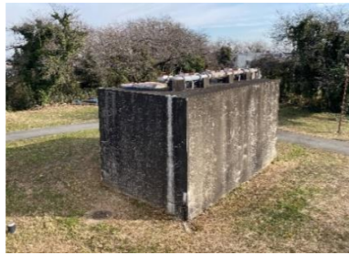
黒岩配水場の配水ポンプ井 (昭和46年築造)
