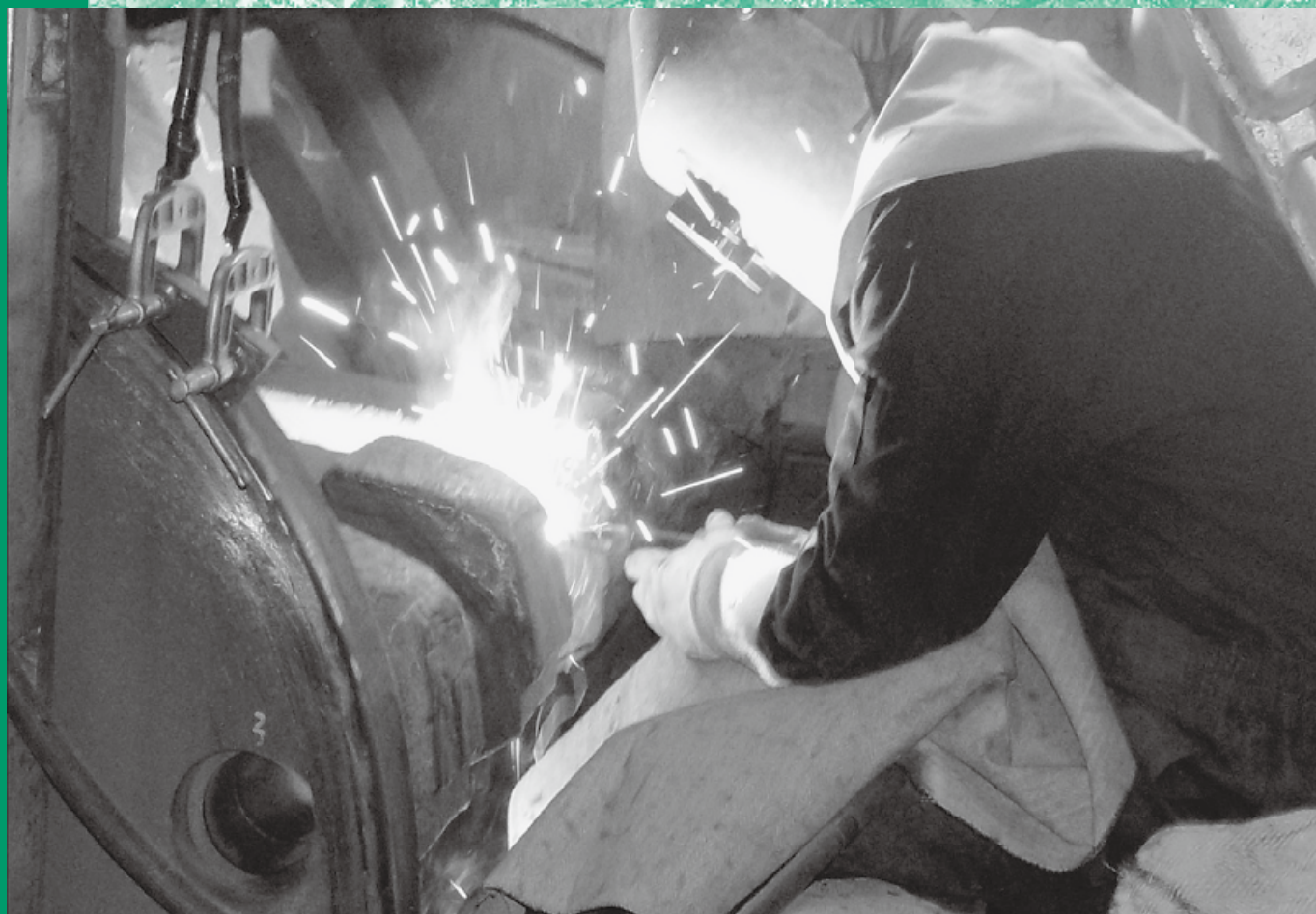
粗大ごみ処理施設の破砕機修繕(6ページに紹介)
