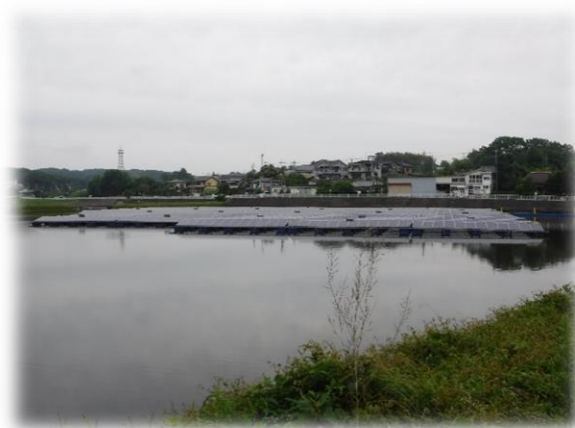
和名沼の太陽光発電設備
